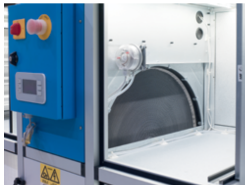
Rotační výměník pro zpětné získávání tepla
